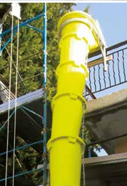
Die Schuttrutsche wird im Bauhandwerk zum bequemen Abrutschen des Abbruchmaterials von höheren Etagen eines Gebäudes verwendet. Damit wird vermieden, dass Passanten und Arbeiter durch Abbruchmaterial verletzt werden.
