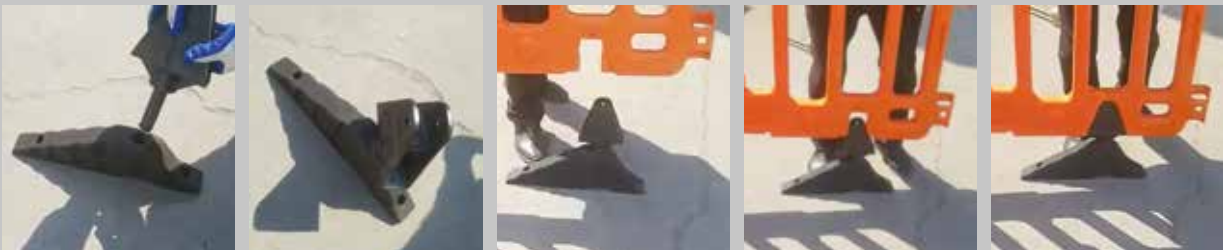
BEFESTIGUNG DER STANDFÜSSE
